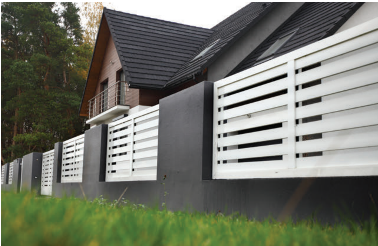
Разреженное заполнение алюминиевым профилем
